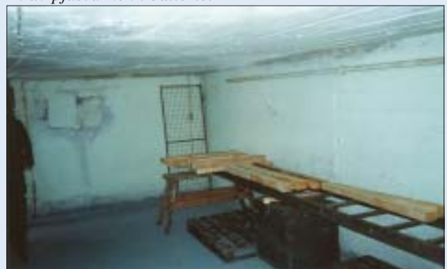
Skyddsrum i batteriet med ny användning
